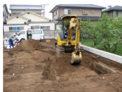
①表土の除去 試掘調査のデータをもとに調査範囲が決まり、重機によって表土を取り除きます。
